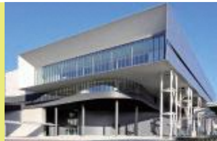
2021年度開所 安川テクノロジセンタ(株安川電機提供)
